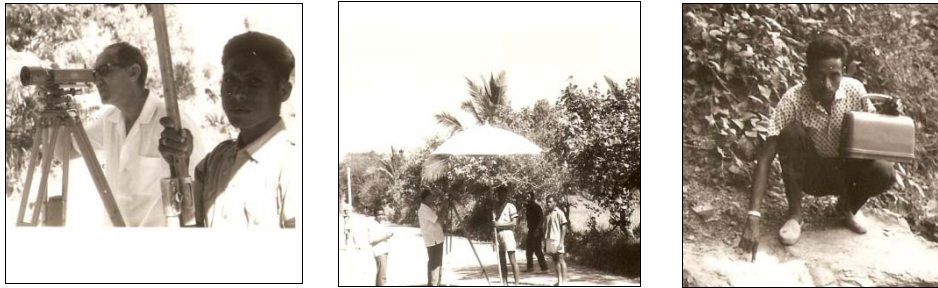
Fig. 11. Fotografias dos trabalhos de nivelamento: observador medindo um desnível com o nível WildT3, nível e mira, indicação do local de uma marca de nivelamento.
